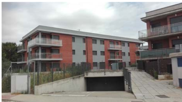
Entrada de l'aparcament subterrani
